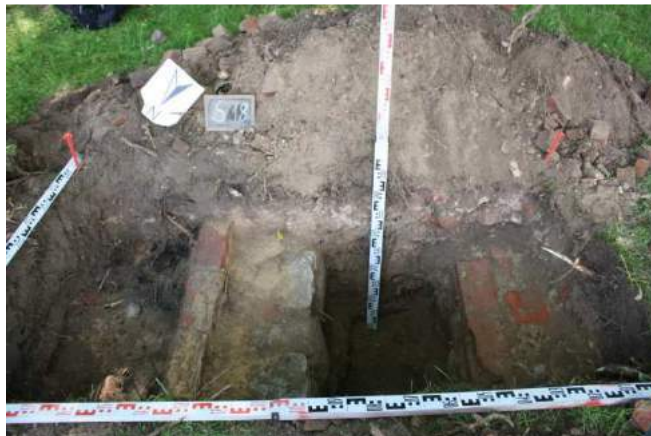
86. Šurfas Nr. 18, pastato Nr. 2 PV sienos ir pastato Nr. 3 ŠR sienos pamatai, gylis 0,35-0,9 m, iš ŠV
