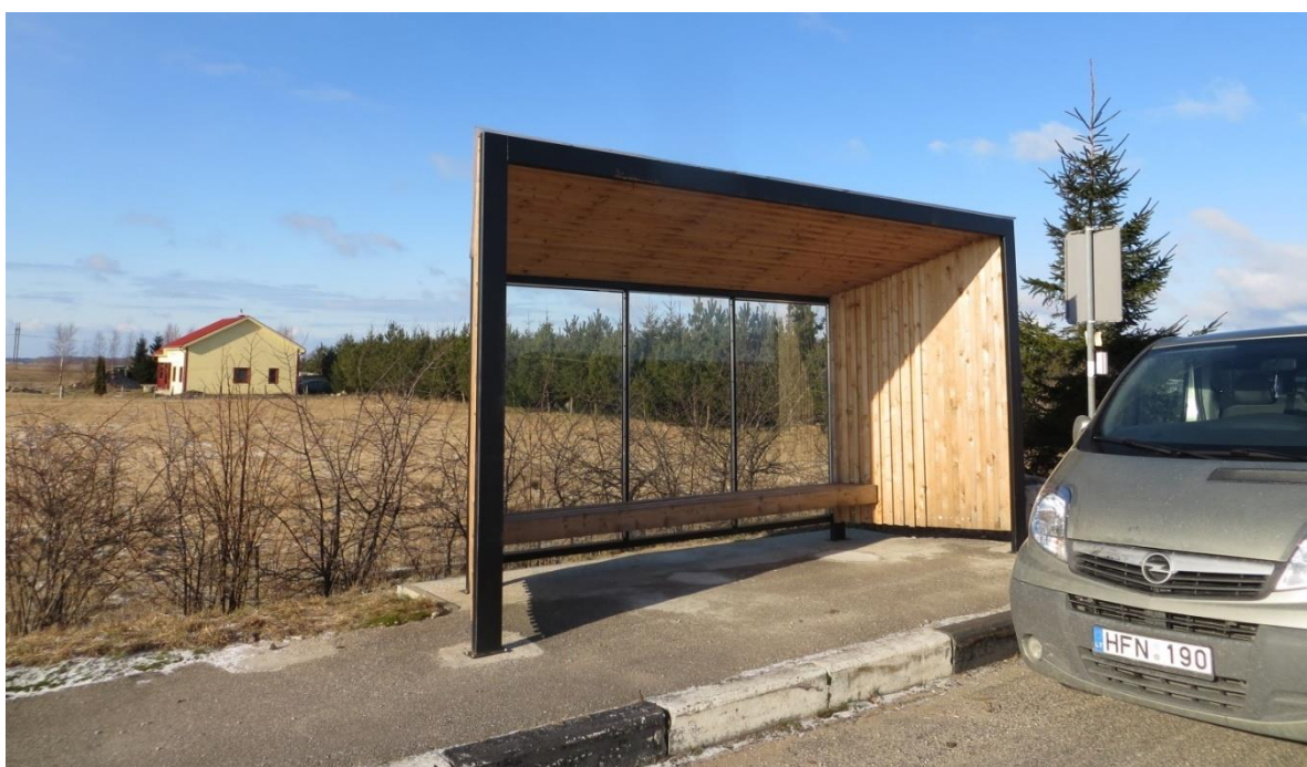
Įrengtas autobuso sustojimo paviljonas
