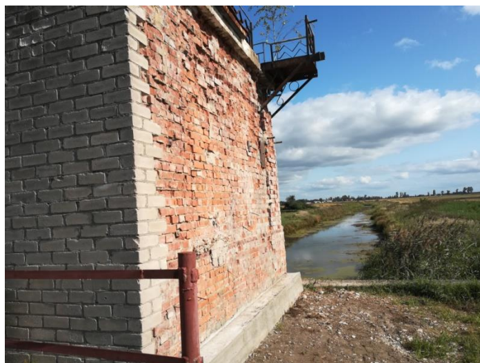
Jokšų polderio siurblinė prieš rekonstrukciją.
