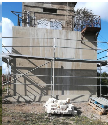
Rekonstrukcijos darbų eigoje, 2019 m.
