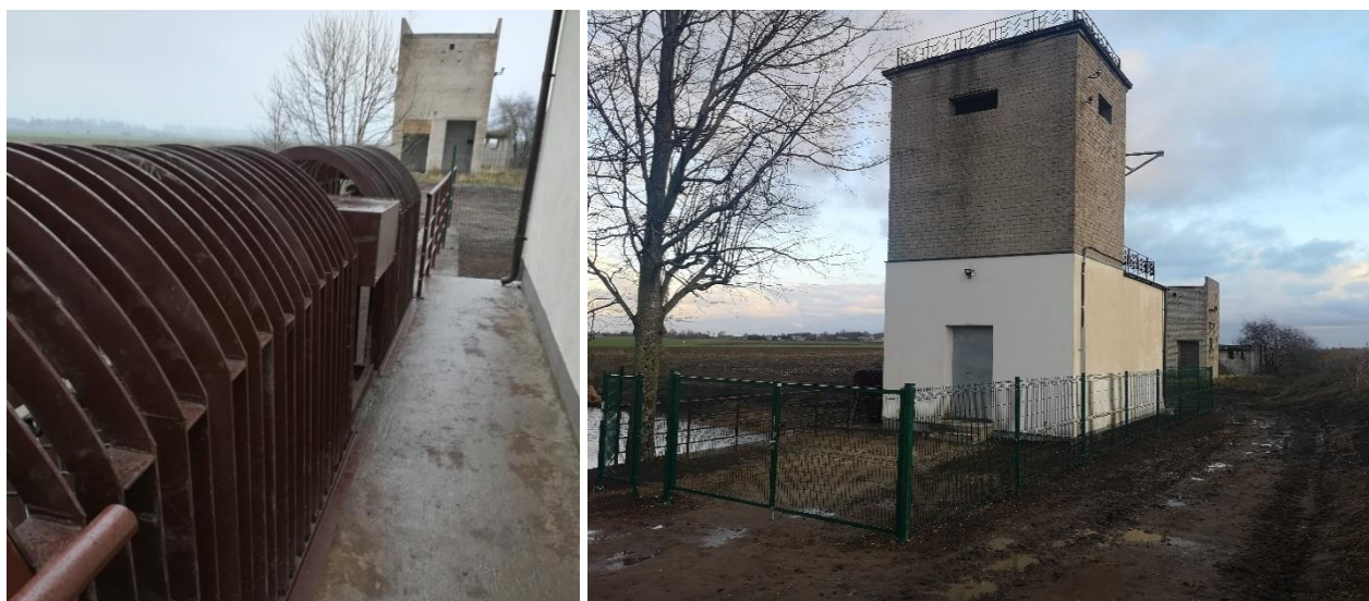
Jokšų polderio siurblynė po rekonstrukcijos, 2019 m.
