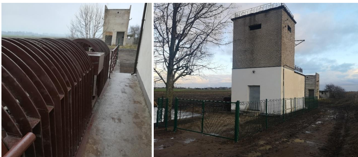
Jokšų polderio siurblinė po rekonstrukcijos, 2019 m.
