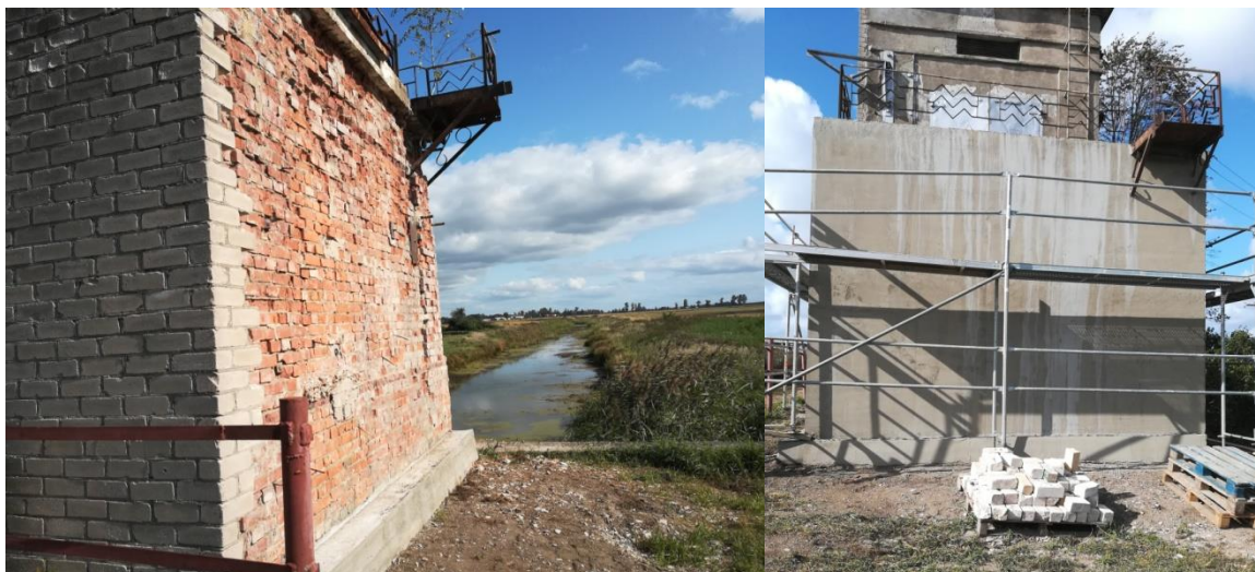
Jokšų polderio siurblinė prieš rekonstrukciją.
