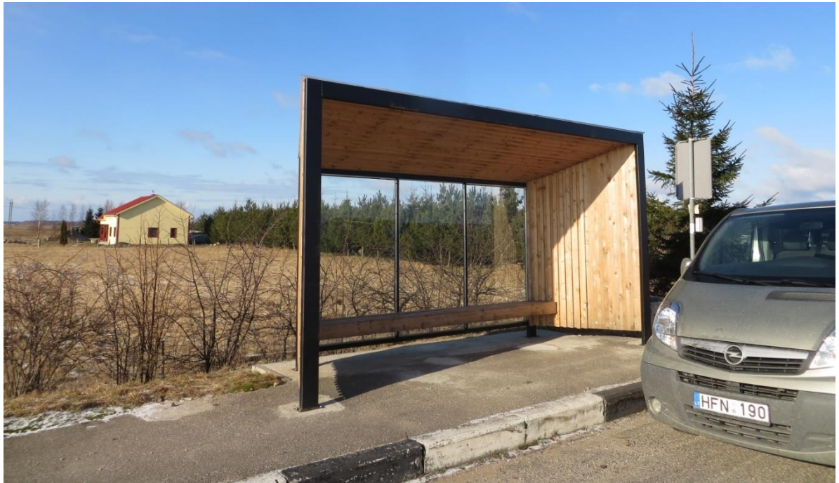
Įrengtas autobuso sustojimo paviljonas
