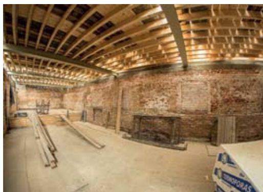
Pradėti Dovylių etninės kultūros centro kapitalinio remonto darbai.
