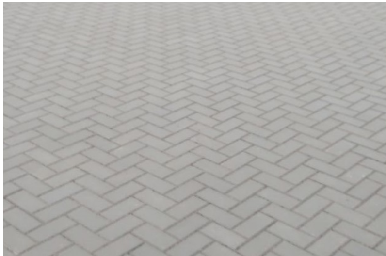
GATVIŲ PRIEIGOMS, PĖSČIŲJŲ TAKAMS ĮRENGTI NAUDOJAMOS KLASIKINĖS PILKOS SPALVOS BETONO TRINKELĖS 1200X900 mm.
