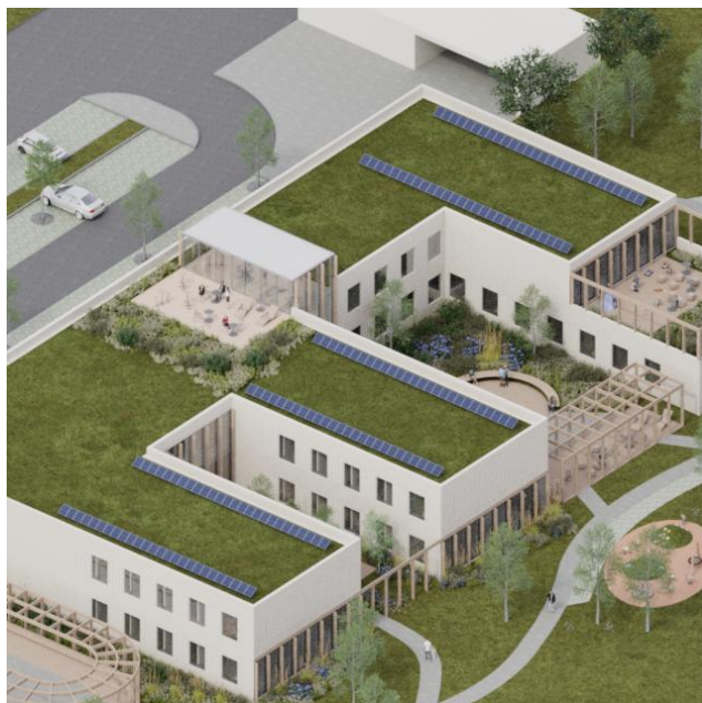
Pav. nr. 8. STOGO VAIZDAS. Fotovoltiniai moduliai ant žalios dangos.
