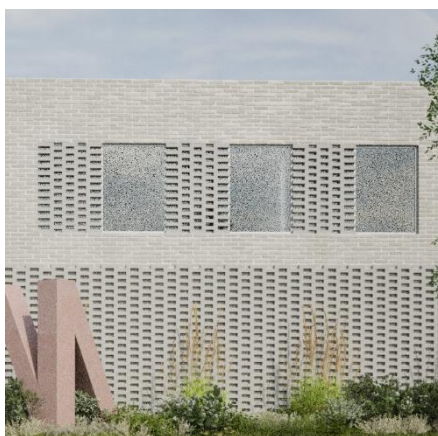
Pav. nr. 7. AŽŪRINIS MŪRAS LANGŲ ZONOJE. Naudojama ažūrinio plytų mūro detalė leidžia saugiai įrengti varstomus į vidų langus natūraliai ventiliacijai ir apsaugoti nuo tiesioginių saulės spindulių.
