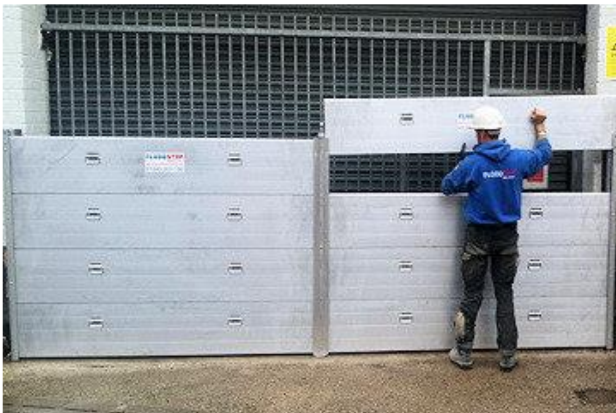
19 pav. Išmontuojama potsvynių užtvara.
