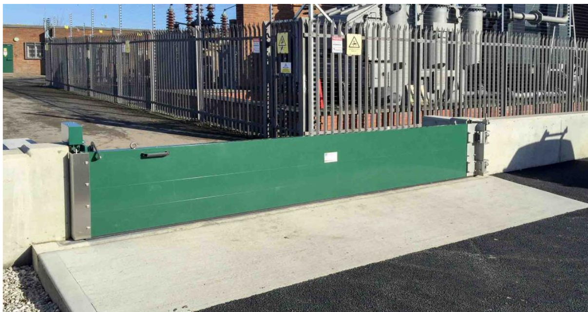
18 pav. Išmontuojama potsvynių užtvara.
