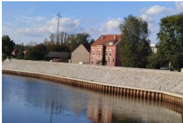
50 pav. Erozijos apsauga, pagrįsta Larseno sienomis ir į betono mišinį įterpta uoliena.
