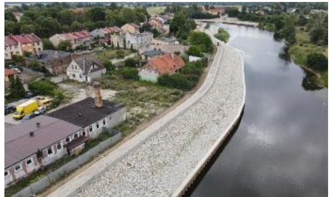
50 pav. Erozijos apsauga, pagrįsta Larseno sienomis ir į betono mišinį įterpta uoliena.
