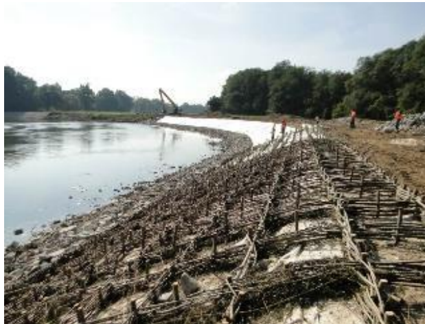
49 pav. Vytelių ir akmenų čiužiniai.
