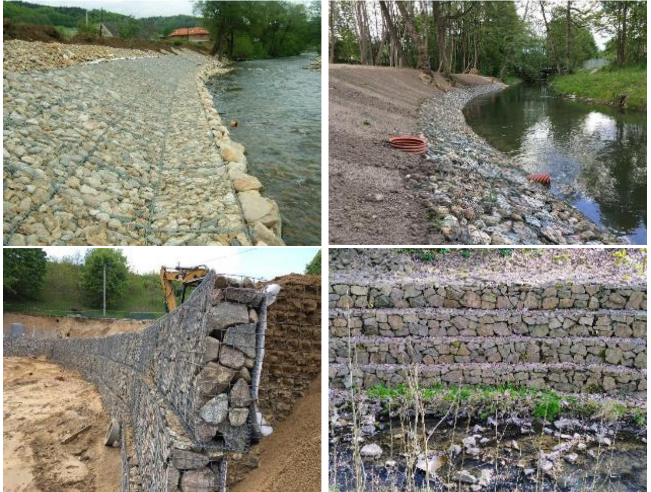
51 pav. Gabionų čiužiniai.
