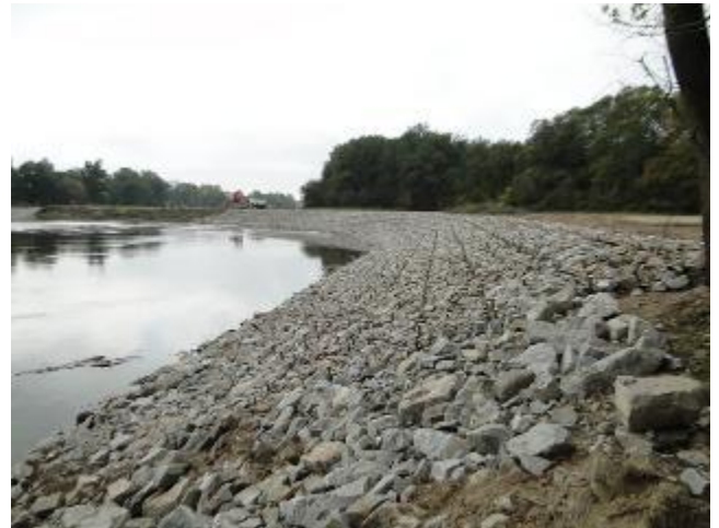
49 pav. Vytelių ir akmenų čiužiniai.
