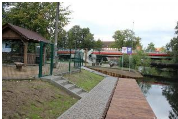
53 pav. Medinė prieplauka įrengta ant polių, krantas sutvirtintas betoninėmis trinkelėmis
