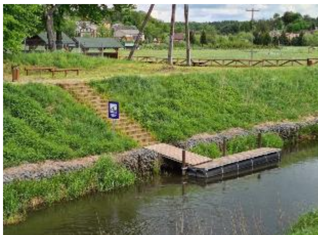
55 pav. Medinė prieplauka įrengta ant plūdurių pritvirtintų prie plieninių polių.
