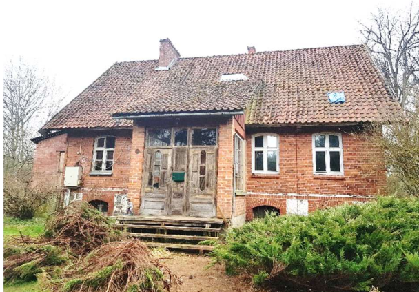
Pastato rytinis fasadas.
