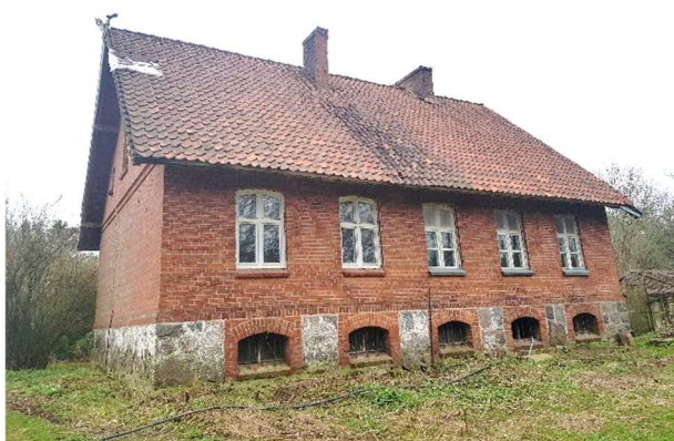
Pastato šiaurės vakarinis fasadas.
